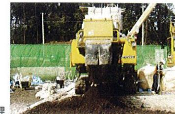
土壤改良機による不溶化処理
